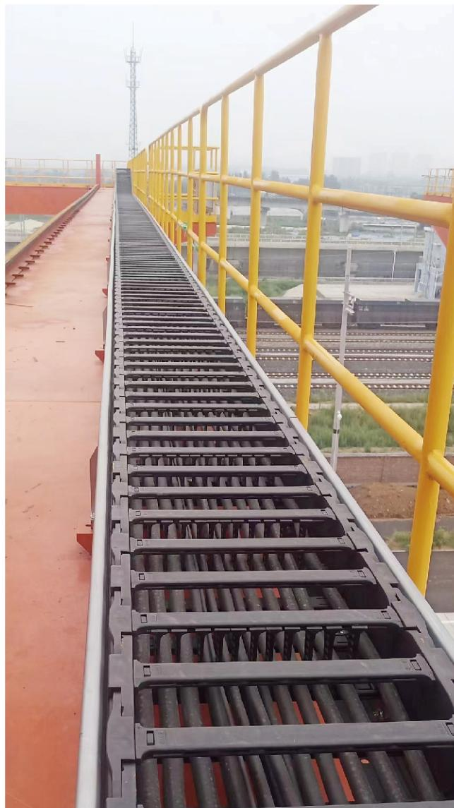
▲如勒动力拖链适用于控制信号、动力、数据等各种种类介质的传输；客户现场可以水平、垂直及环状安装应用。
